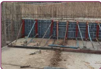
MES Hospital (Himachal Pradesh)
